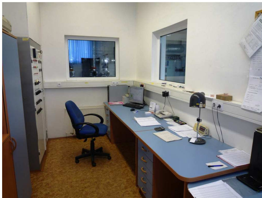
Dispečerské pracoviště na kotelně OKD na ul. Čs. armády
